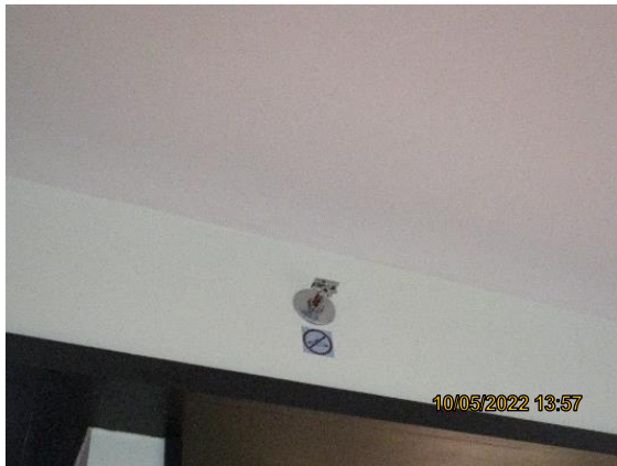
รูปที่ 2.10-7 ระบบสปริงเกอร์บริเวณห้องพัก
