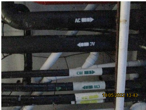
รูปที่ 3.1-27 การจัดระบบท่อประปาให้เป็นระเบียบ และแยกสีประเภทของน้ำ
