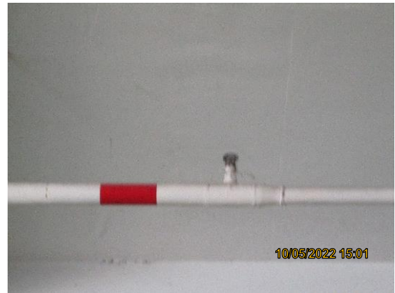
รูปที่ 2.10-8 ระบบสปริงเกอร์บริเวณลานจอดรถ
